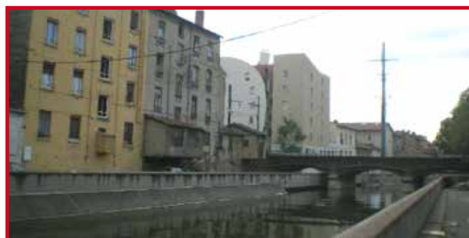
▲ 41-43 rue Pierre Sépard, immeubles préemptées voués à démolition
