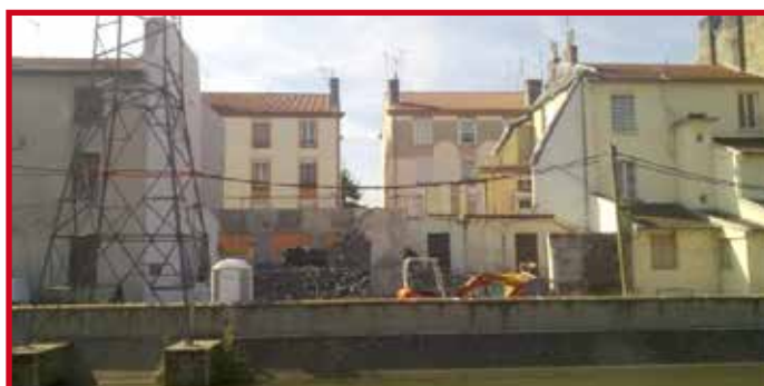
▲ 67-69 rue Pierre Sépard en cours de démolition en 2010
