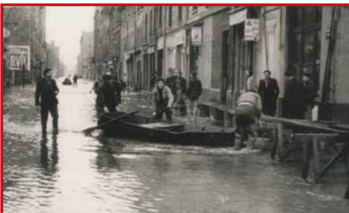
▲ Inondation de la Saulaie (plus d'un mètre d'eau dans les rues)
