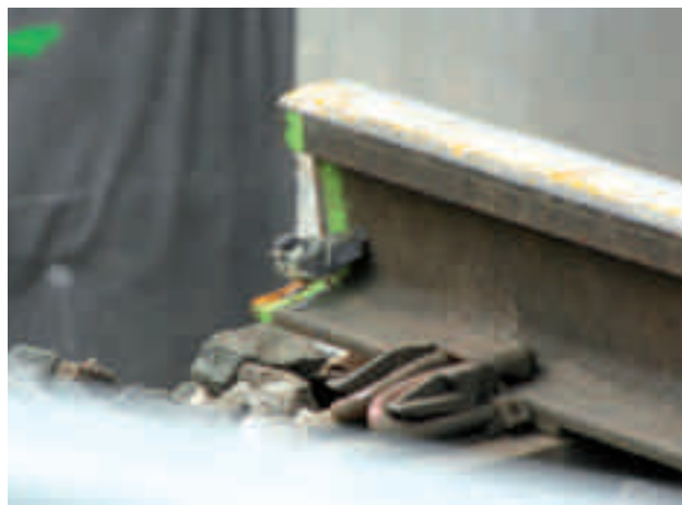
2 e : Yvette Charles Une mésange surveille le chantier du métro
