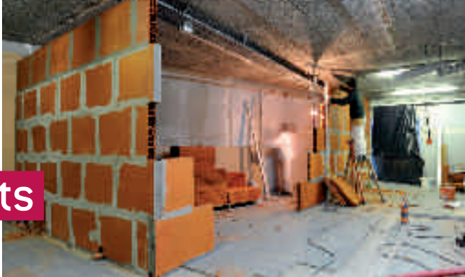
Au gymnase Herzog, les vestiaires sont entièrement refaits.
