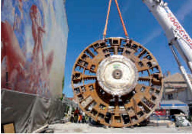
16 mai, extraction de la roue de coupe, puits Orsel
