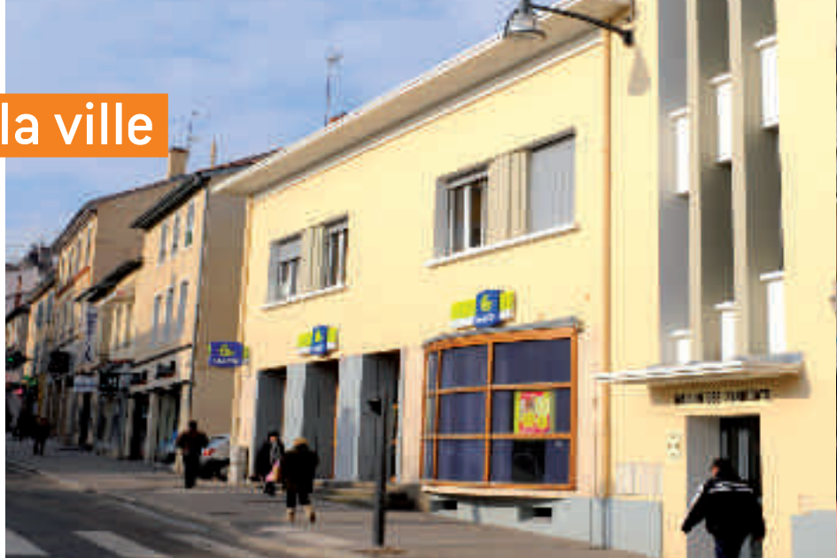
Le 1 er février 2010 marquait la fin du délai accordé pour procéder à la rénovation des façades, expliquant l'apparition de nombreux échafaudages ces derniers mois tout au long de la Grande rue.
