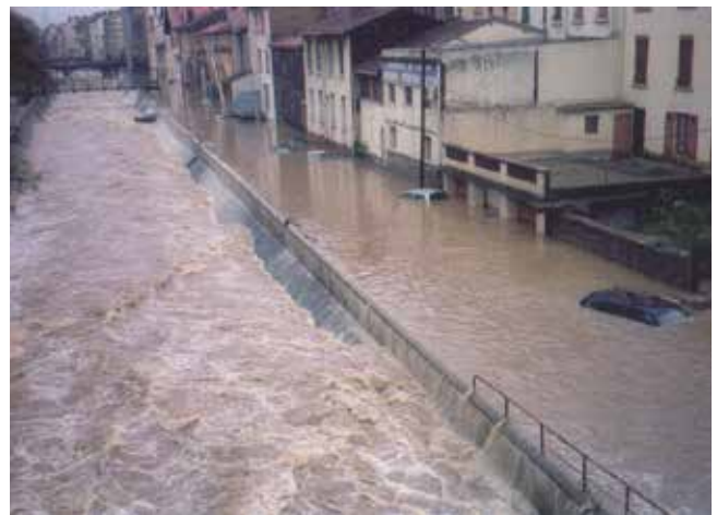
▲ Crue de l'Yzeron quai Pierre Sébard
